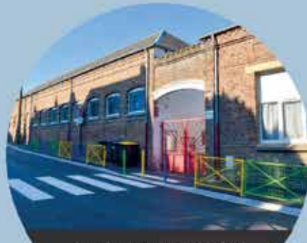
Aménagement et mise aux normes des bâtiments
