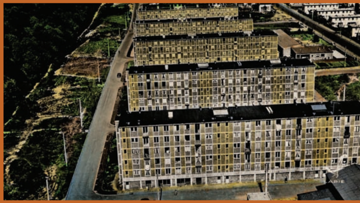
Immeubles de l'Opération Million (Bois-du-Quesnoy), construits entre 1955 et 1957, et démolis dans les années 1980. Ils illustrent les problèmes sociaux générés par ce type d'habitat collectif.
