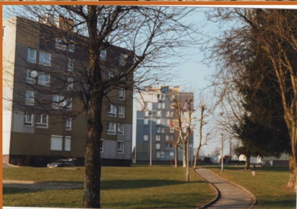
Cité Exotique construite dans les années 1970 (Rive Gauche). Elle est composée de huit immeubles et du Figuier (un habitat collectif semi-individuel)
