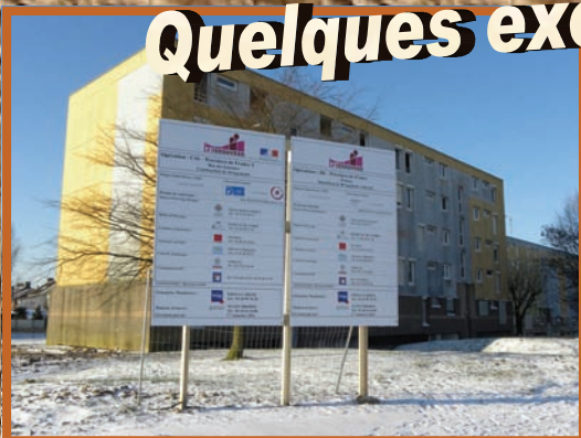
Démolition des barres «Provinces françaises» sur l'année 2009 et 2010. Les immeubles Waudru & Madelgaire ont été aussi démolis.
