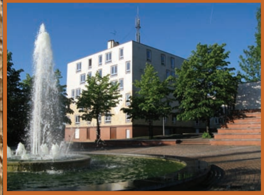
Les immeubles Waudru & Madelgaire, situés rue Gambetta et démolis en février 2009, avaient été construits de 1974 à 1976. Ils comprenaient alors 40 logements collectifs. Ils visaient déjà à résorber l'îlot insalubre Saint-Ansbert, peuplé dans les années 50-70 de taudis.
