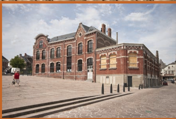
Ancienne école Géhu rénovée place des Bateliers
