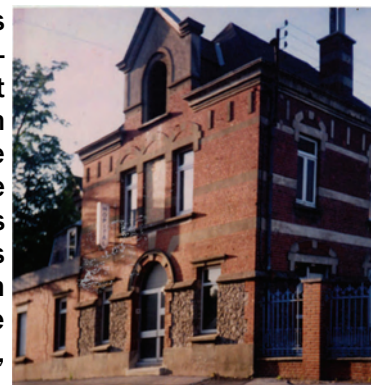
Ancien hôpital d'Hautmont
