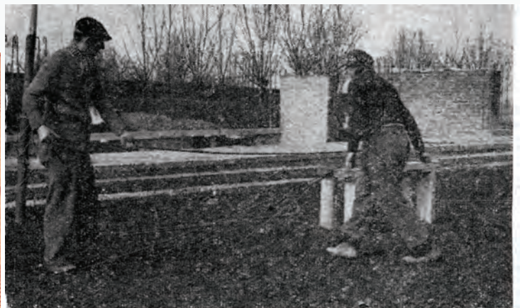
On embauche ! Deux des hommes du quartier qui construisent eux-mêmes leur chapelle.
