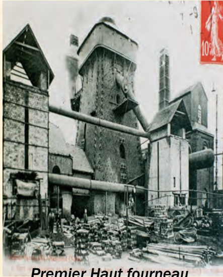
Premier Haut fourneau
